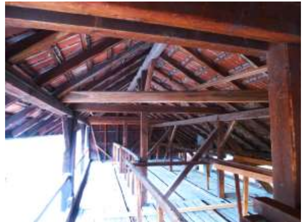
Abb. 5: Innenansicht eines Betriebsgebäudes
