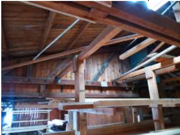
Abb. 4: Innenansicht eines Betriebsgebäudes
