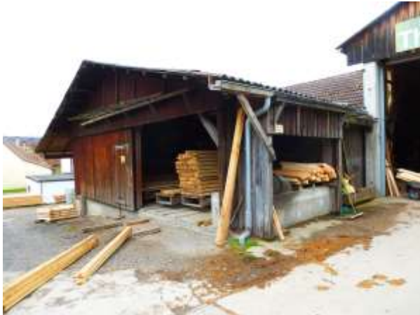
Abb. 2: Außenansicht des Gebäudekomplexes
