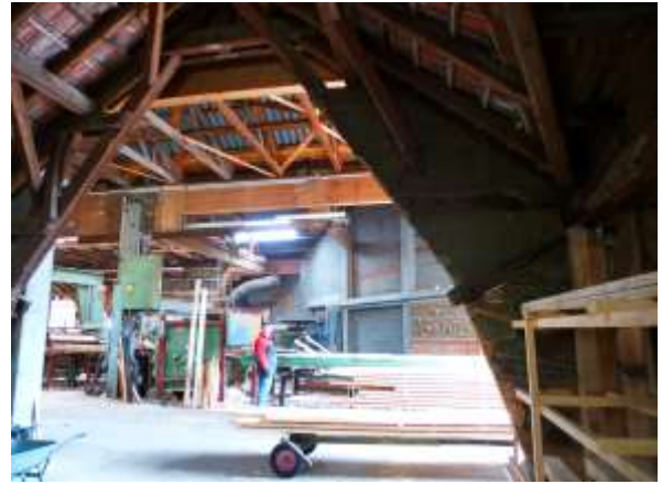
Abb. 3: Innenansicht eines Betriebsgebäudes
